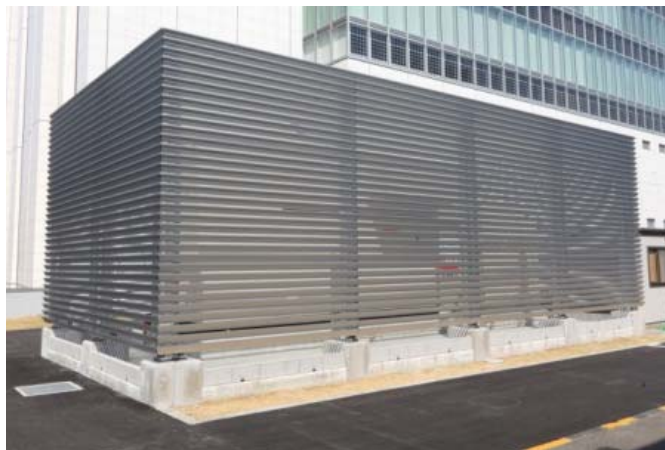
非常用電源として自家発電装置を設置
