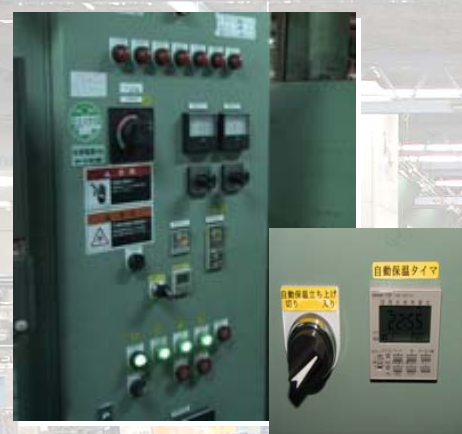
変成炉タイマーと回路を改造
